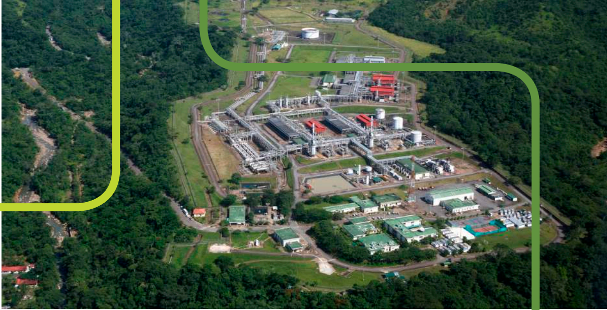
Ecopetrol, Campo Cupiagua. Departamento del Casanare
