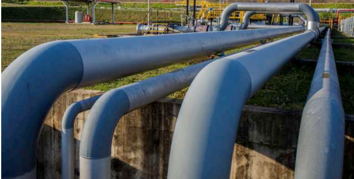
Ecopetrol. Estación de transporte Araguaney. Departamento de Casanare.
