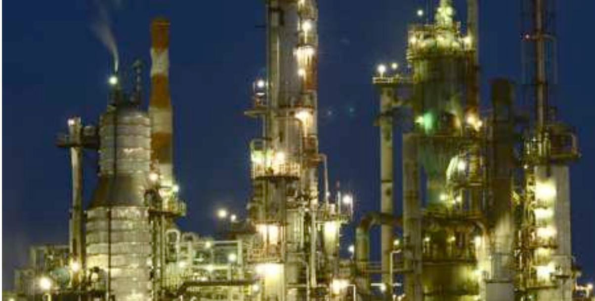
Ecopetrol. Planta Orthoflow de la Refinería de Barrancabermeja. Departamento de Santander.
