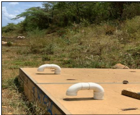
Imagen No. 3. Cajas de Válvulas de la Línea de aducción a PTAP El Pórtico de Subproyecto 1 del sistema de AMFPS de Cúcuta.
