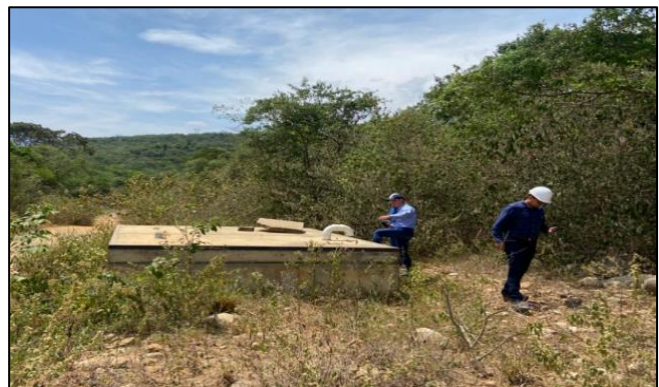
Imagen No. 3. Cajas de Válvulas de la Línea de aducción a PTAP El Pórtico de Subproyecto 1 del sistema de AMFPS de Cúcuta.
