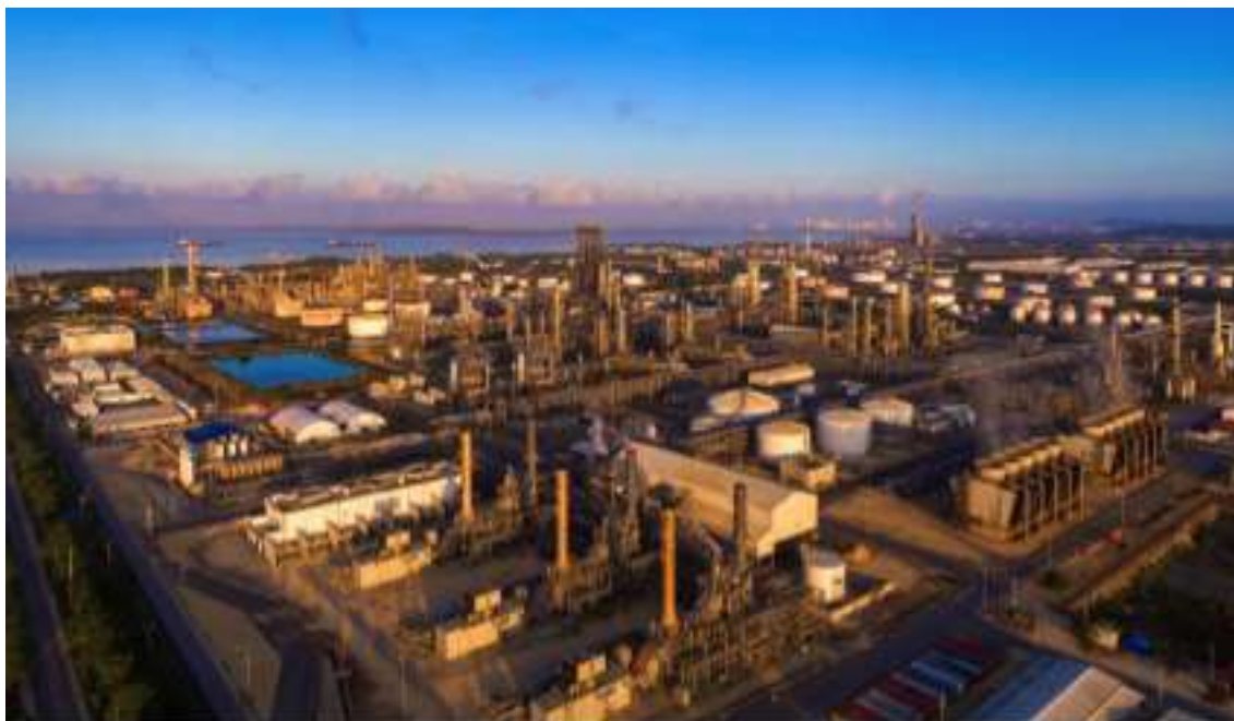
Vista panorámica de la Refinería de Cartagena
