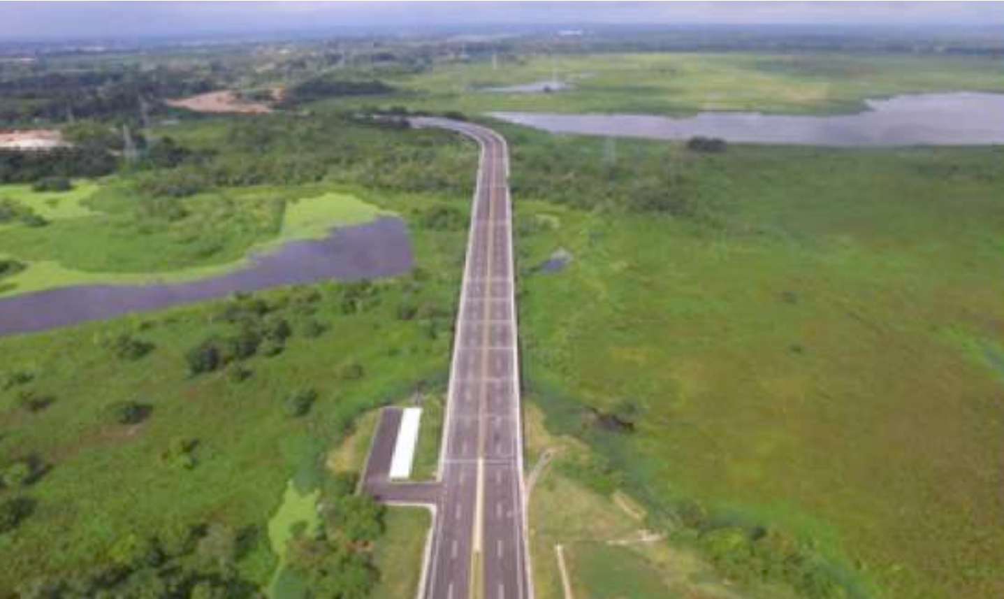
Construcción de la Gran Vía Yuma, en el Magdalena Medio
