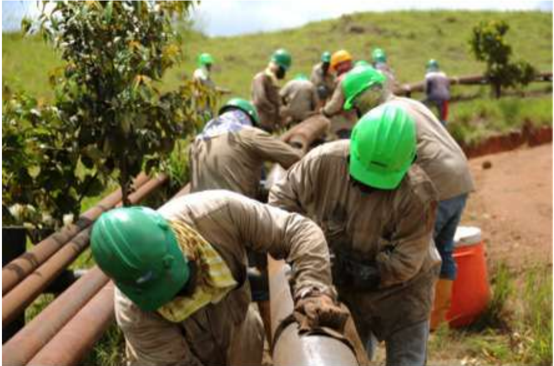
Trabajadores de contratistas realizando actividades de mantenimiento en la infraestructura de oleductos, en Campo Rubiales (Meta).
