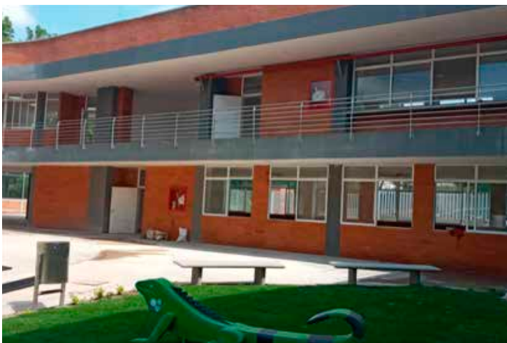
Construcción fase II colegio La Fortuna
